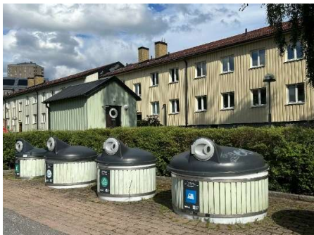
Bild 4 – Avfallsbehållare och återvinningsrum mellan hus B och hus C.
