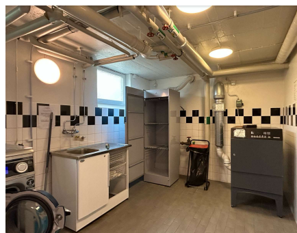
Bild 3 - Tvättstuga i hus A
